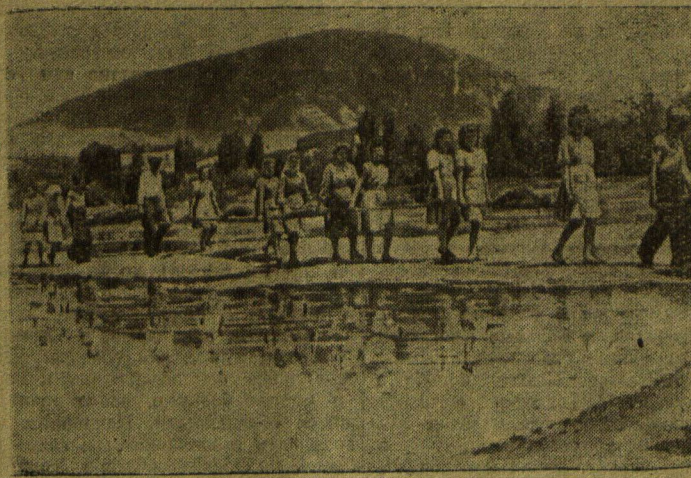
На снимке: учащаяся и рабочая молодежь на стройке водного бассейна.
